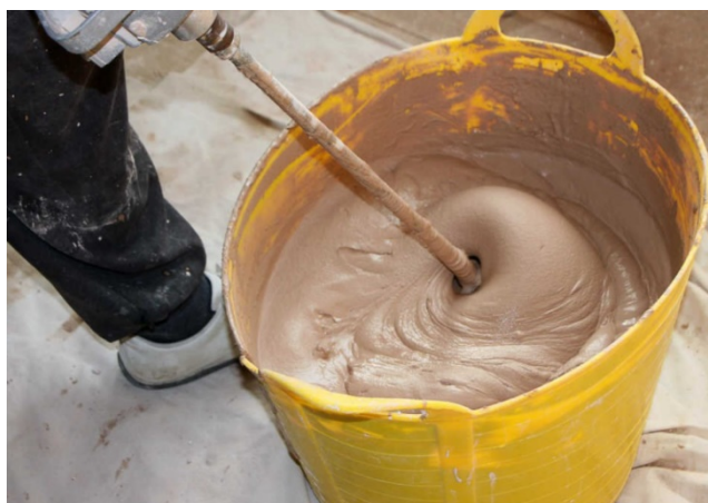
Рис. 1. Приготовление раствора
