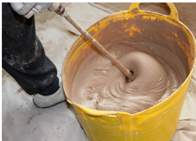
Рис. 1. Приготовление раствора
